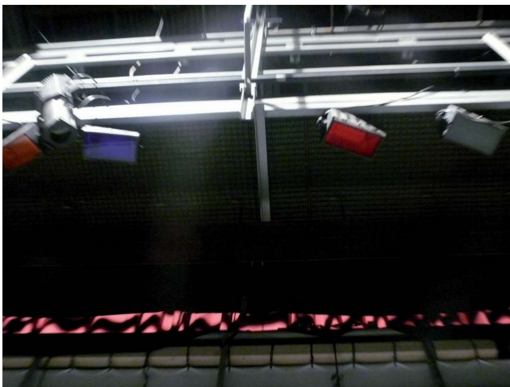
Světelné vybavení na jevišti
